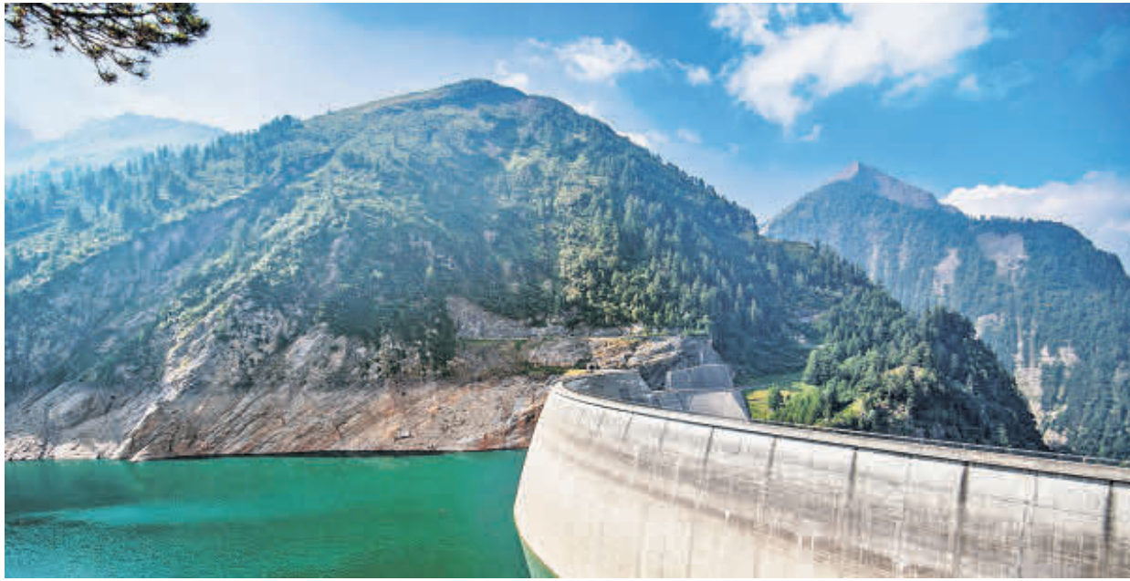
La diga del Luzzone fu innalzata di 17 metri negli anni Novanta.
